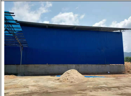
堆场三面围挡+顶棚
