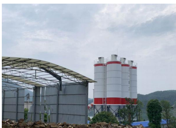
搅拌设施自带布袋除尘器
