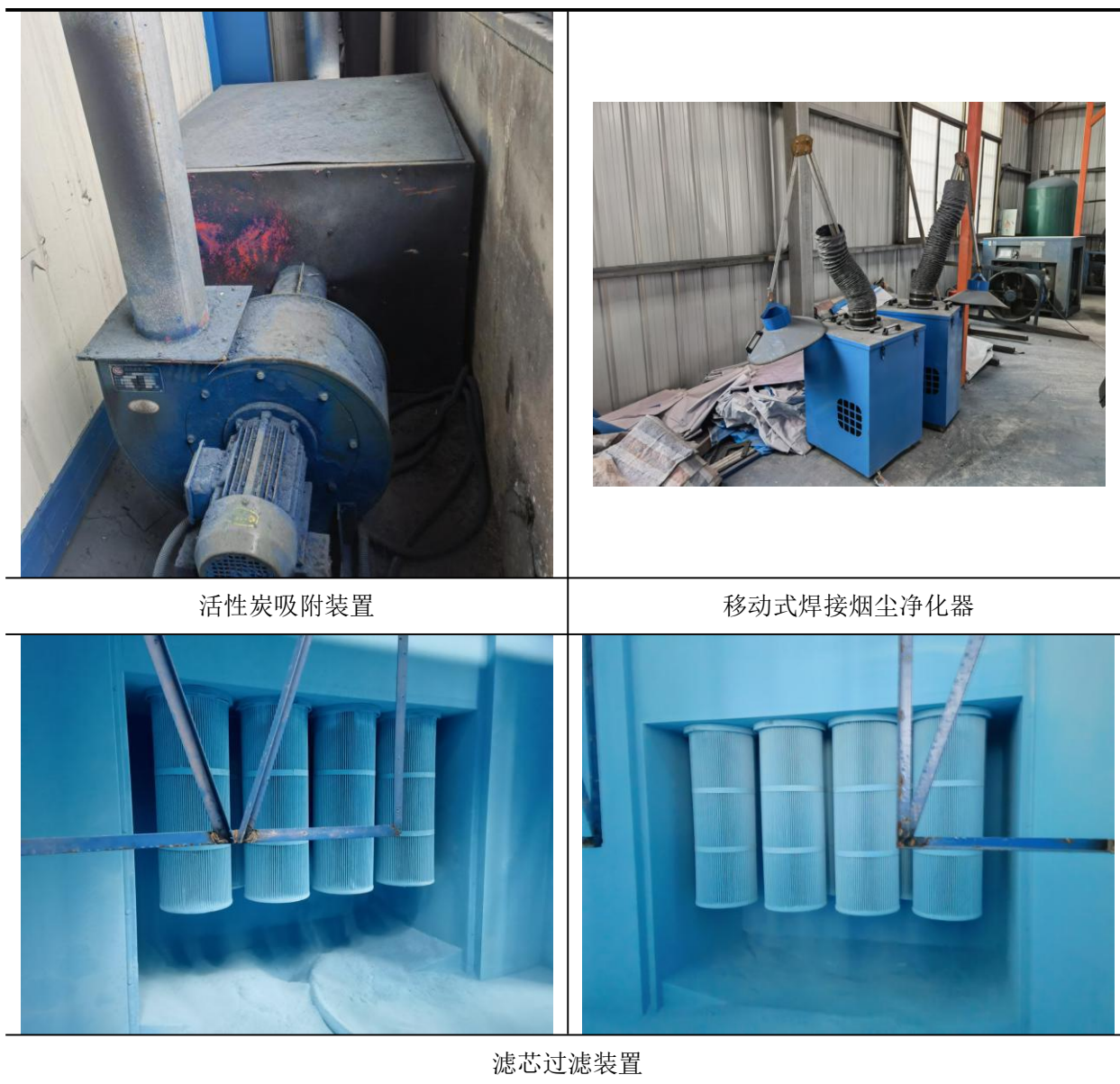
图 4-2 废气处理设施照片
